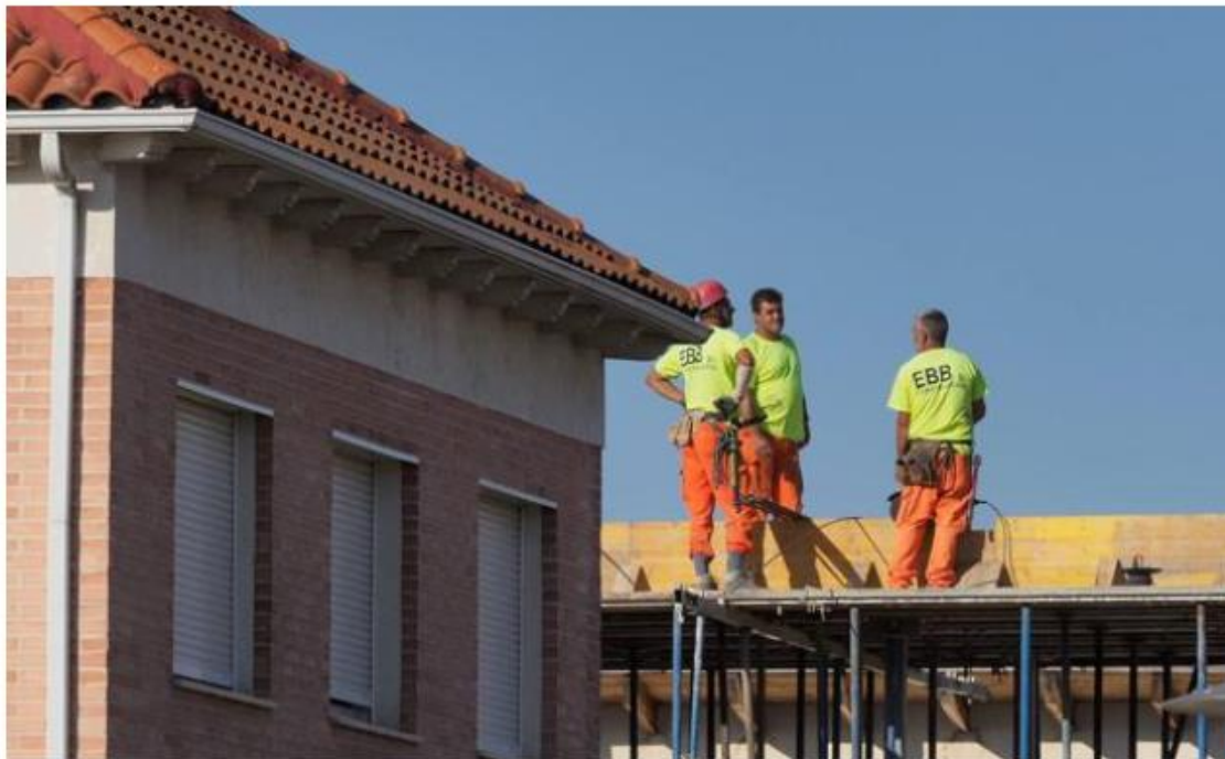
Trabajadores en una obra. / EFE
